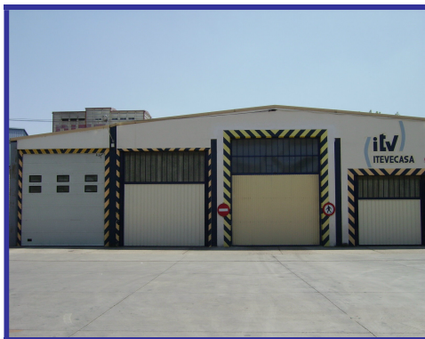
Figura 7. Nave líneas inspección
